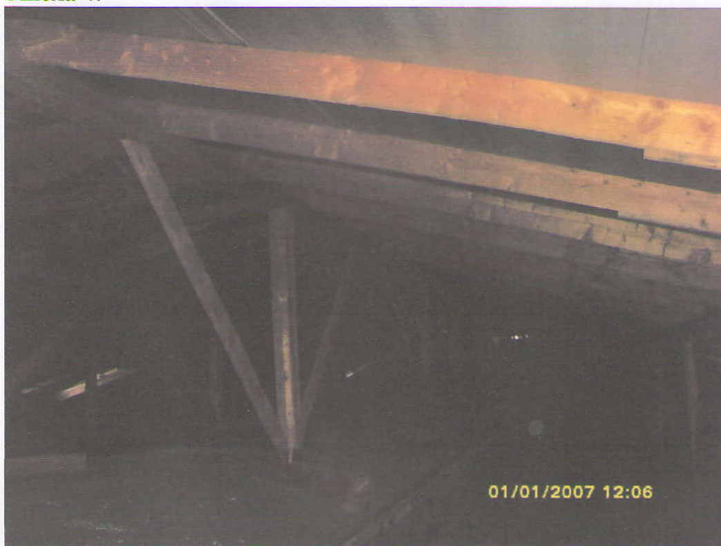
l: Anexa 4: Alcătuire acoperiș șarpantă.
